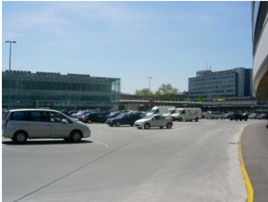
Parking- 1. Geschoss in Richtung Postauto-Bahnhof
