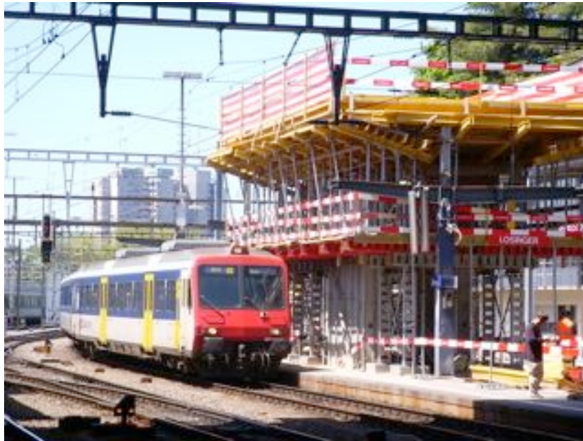
Baustelle von neuer Passerelle
