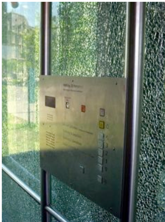
Schanzelift Armatur mit Zerstörter Scheibe. Fotografiert beim einsteigen auf der Schanze
