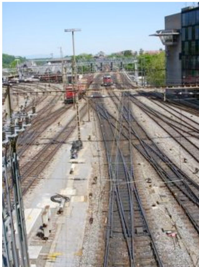
Die Einfahrt der von Zürich vom Parking 1. Geschoss
