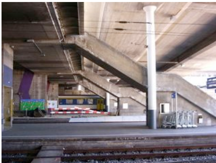
Aufgänge zur Passerelle Schanzenstrasse von Gleis 9/10 aus
